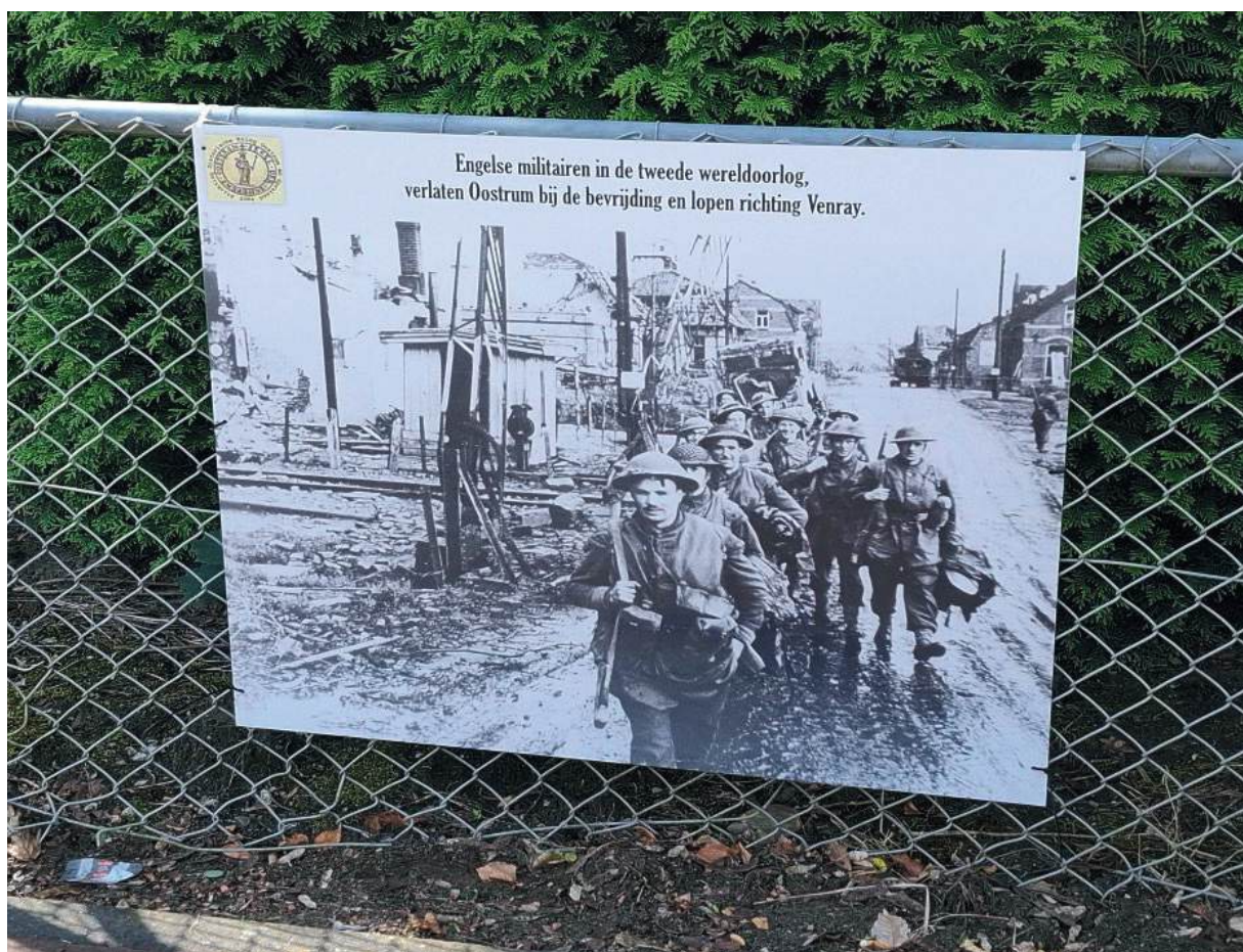
Foto 1: Geplaatst aan het hekwerk bij de spoorwegovergang.
