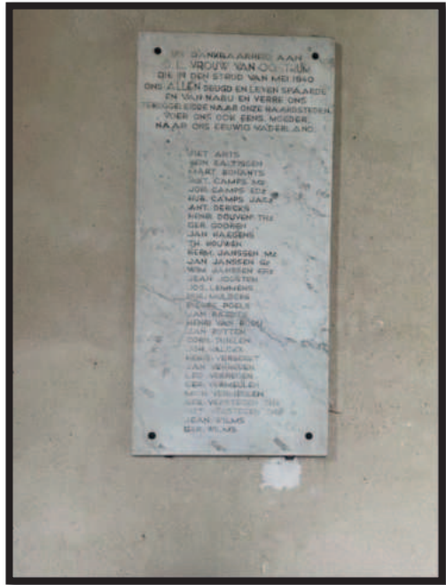
Voor de renovatie:
