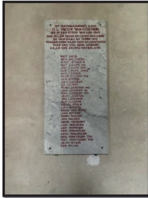
Na de renovatie:
