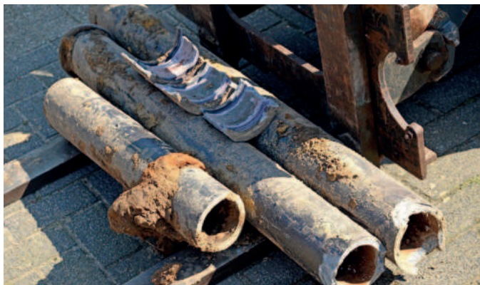
De oude waterleidingbuizen.
